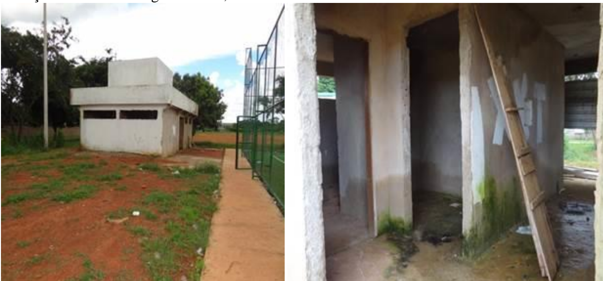
Situação da obra de Vargem Bonita, em 25/03/2015
