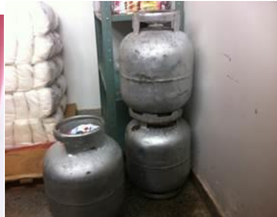
Armazenamento irregular de botijões de gás liquefeito
