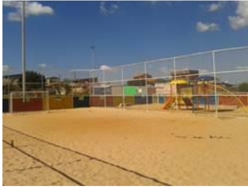
Campo e parquinho construídos em posição invertida
