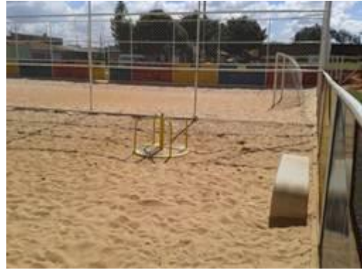
Banco de concreto e brinquedo mal conservado
