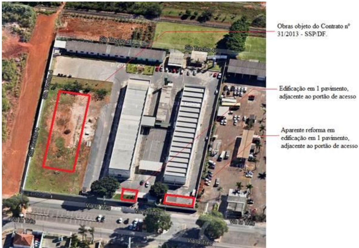
Figura 1: Imagem da área de abrangência das instalações do CPP e obras inspecionadas.
