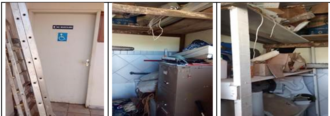
Foto 1 – SANITÁRIOS PARA DEFICIENTES USADOS COMO DEPÓSITOS
