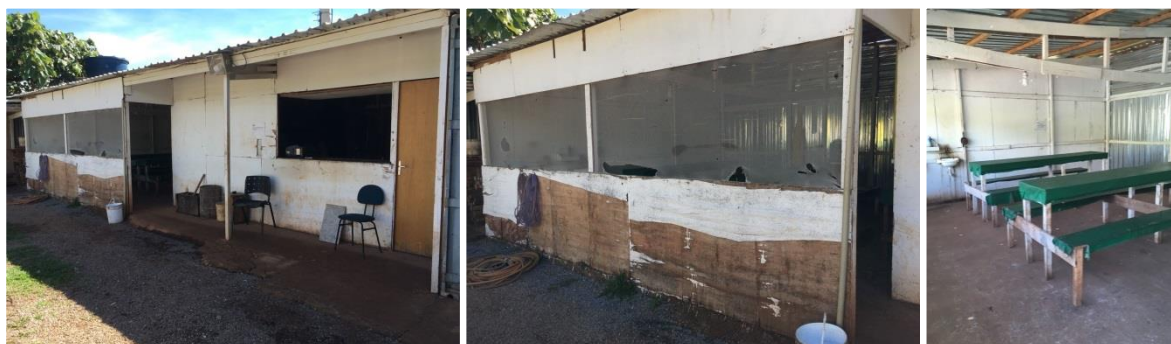
Figura 6 - Fotografias do galpão aberto (item 03.06) retiradas pela Equipe de Inspeção em 5/3/2018.
