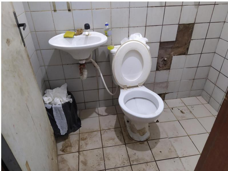
Imagem 8: banheiro da sala utilizada pela Diretoria de Obras com sujeira e falta de azulejo.
