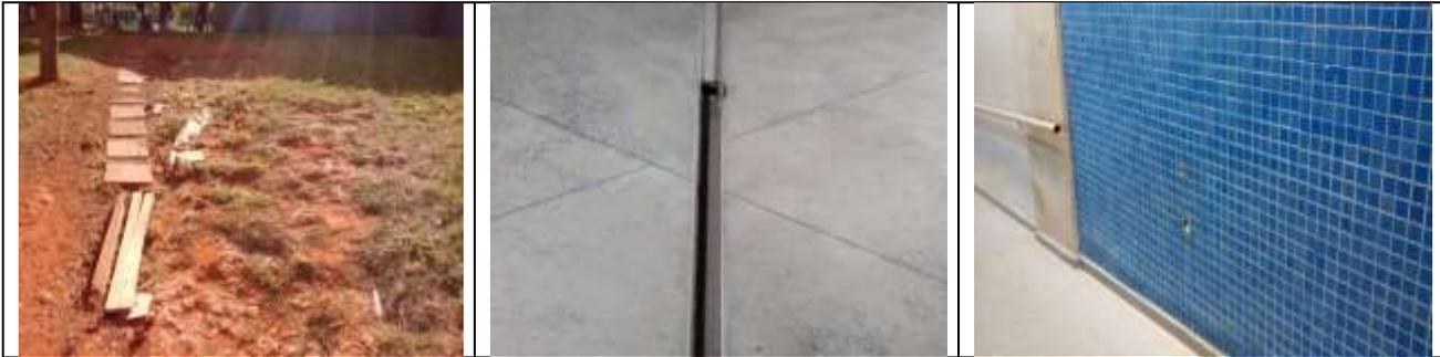
Figura 3 – As imagens acima mostram que na Estação 114 Sul (da esquerda para direita) falta piso na parte externa da estação, pisos internos sem grelhas (possivelmente vandalizados) e corrimões inacabados.
