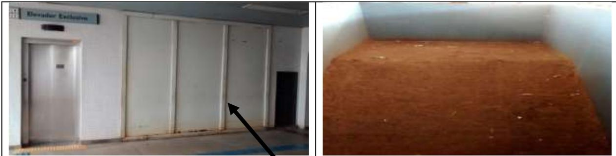
Figura 1 – Ao lado do elevador (foto da esquerda) existe tapume bloqueando o vão (foto da direita) onde poderia ser construída uma rampa para pessoa com deficiência ou mobilidade reduzidas.
