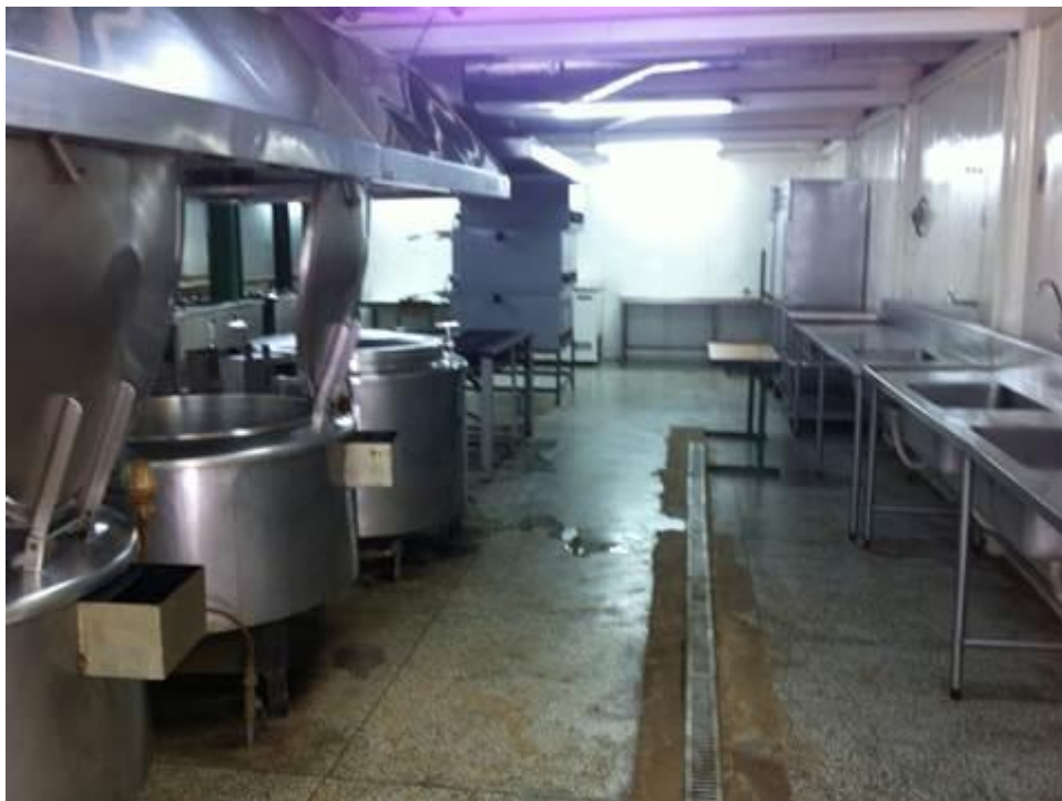
Foto retirada na área de preparo de refeições, no Caic Unesco de São Sebastião
