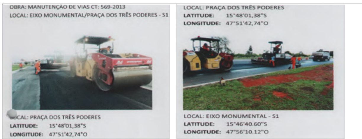
Figura 10 – Quantidade de Rolos de Compactação Utilizados na Execução
