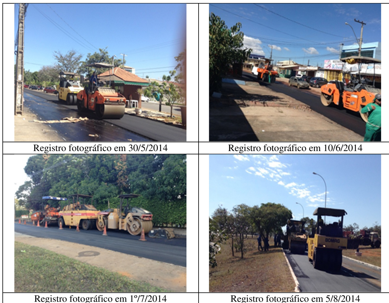
Figura 11 – Quantidade de Rolos de Compactação Observados in Loco
