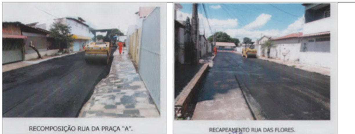
Figura 9 – Quantidade de Rolos de Compactação Utilizados na Execução
