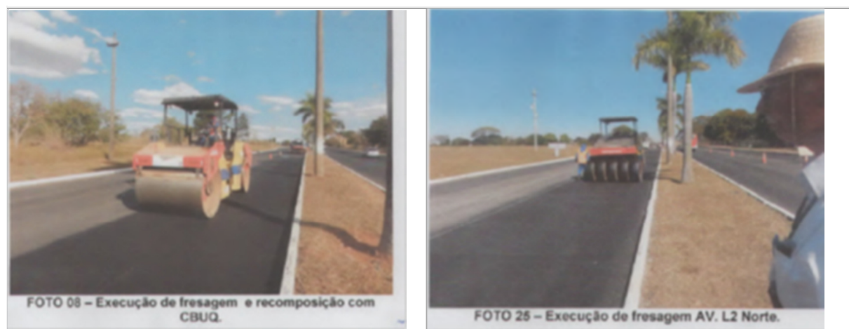
Figura 8 – Quantidade de Rolos de Compactação Utilizados na Execução
