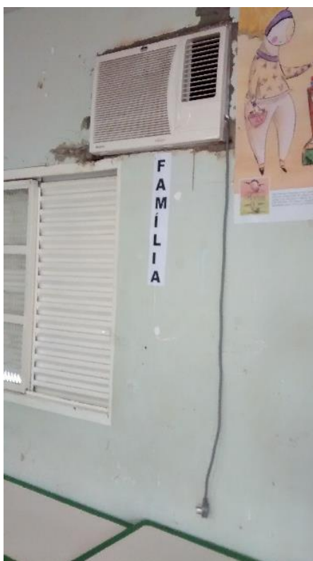
Aparelhos de ar condicionado sem instalação elétrica para funcionar
