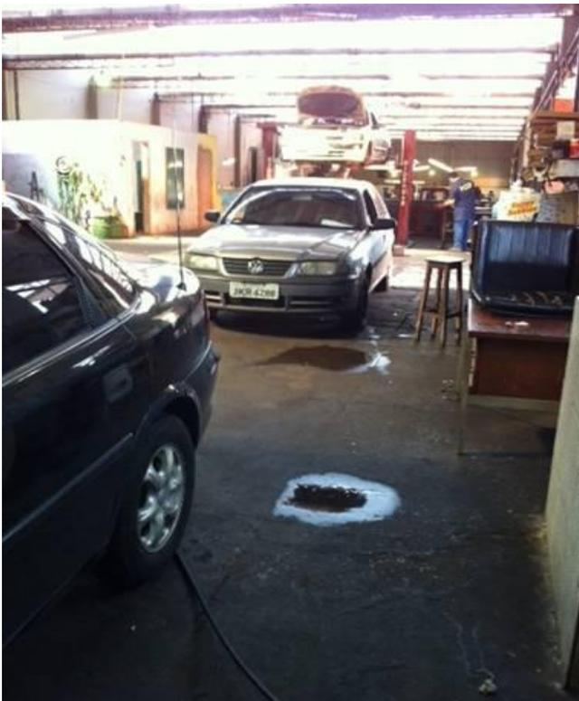
Foto 4: Poças d'água em virtude de goteiras no telhado da oficina de veículos
